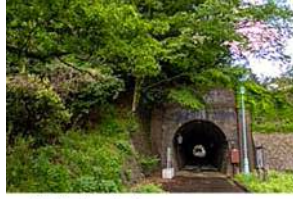
檜曲トンネル-3(16MB).jpg
