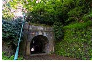
檜曲トンネル-2(16MB).jpg
