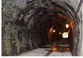
檜曲トンネル-1(3MB).JPG
