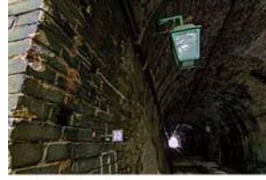
檜曲トンネル-4(11MB).jpg
